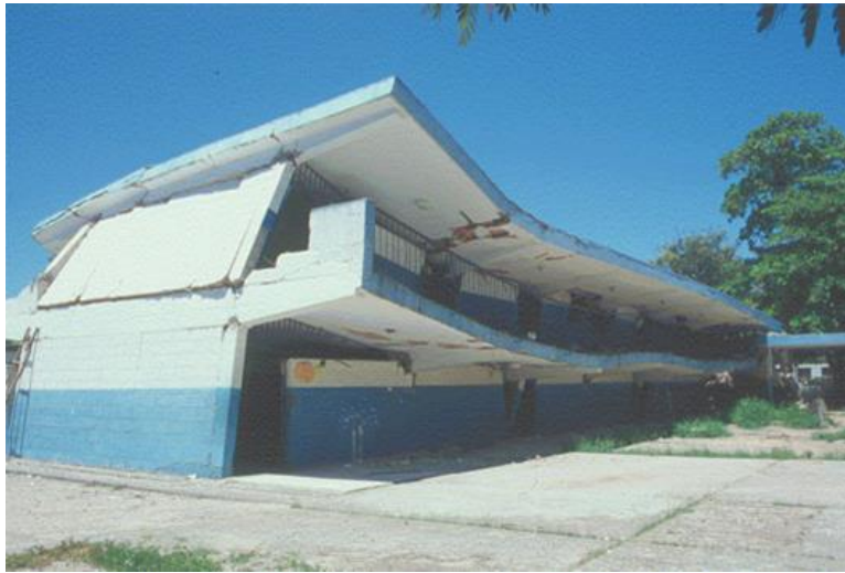
Figura 2-4. Afectación por el Terremoto de 1997 en la Escuela Básica Valentín Valiente de Cariaco, Estado Sucre
