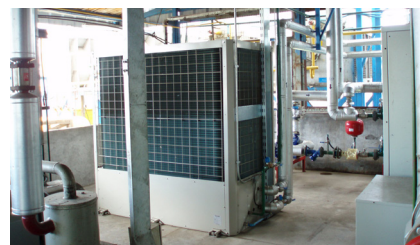
Bomba de Calor
