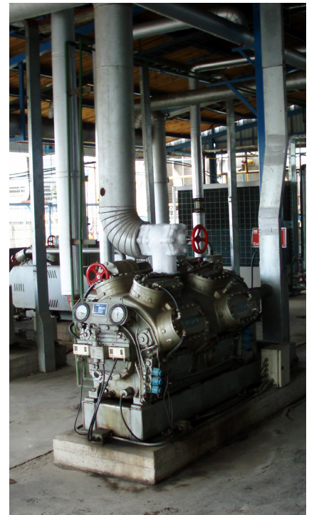
Sala de máquinas amoníaco - glicol
