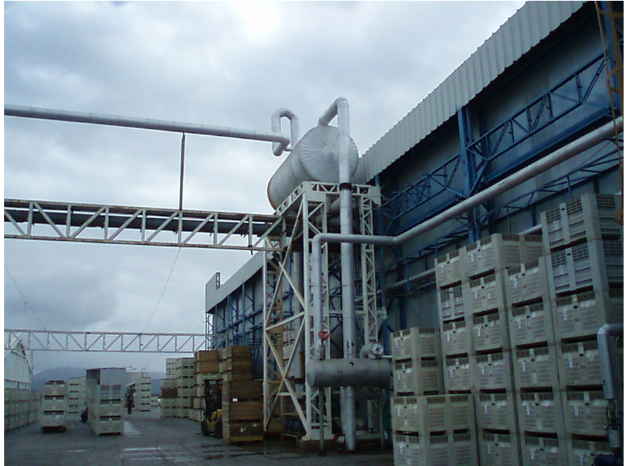
Sistema de refrigeración
