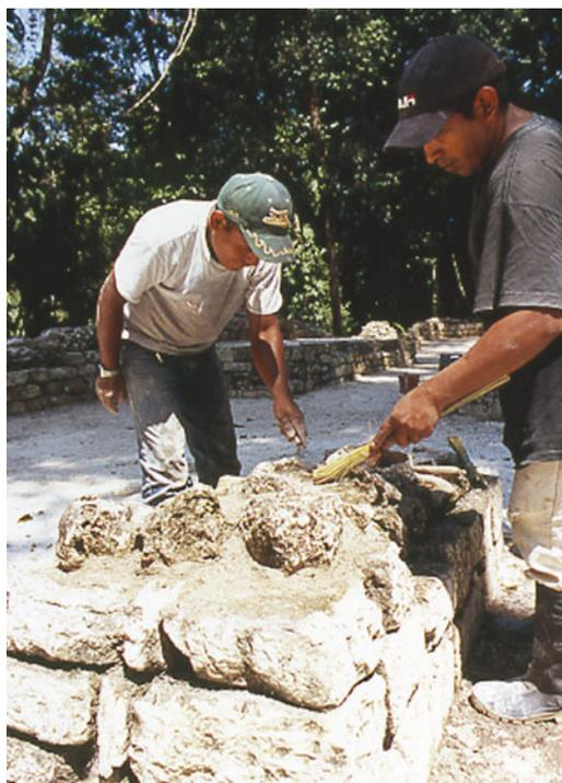
**De vez en cuando los albañiles hacen una mezcla de cemento que no se solidifica correctamente. Estos trabajadores tuvieron que dismantelar los muros que habían restaurado y volverlos a hacer.**
