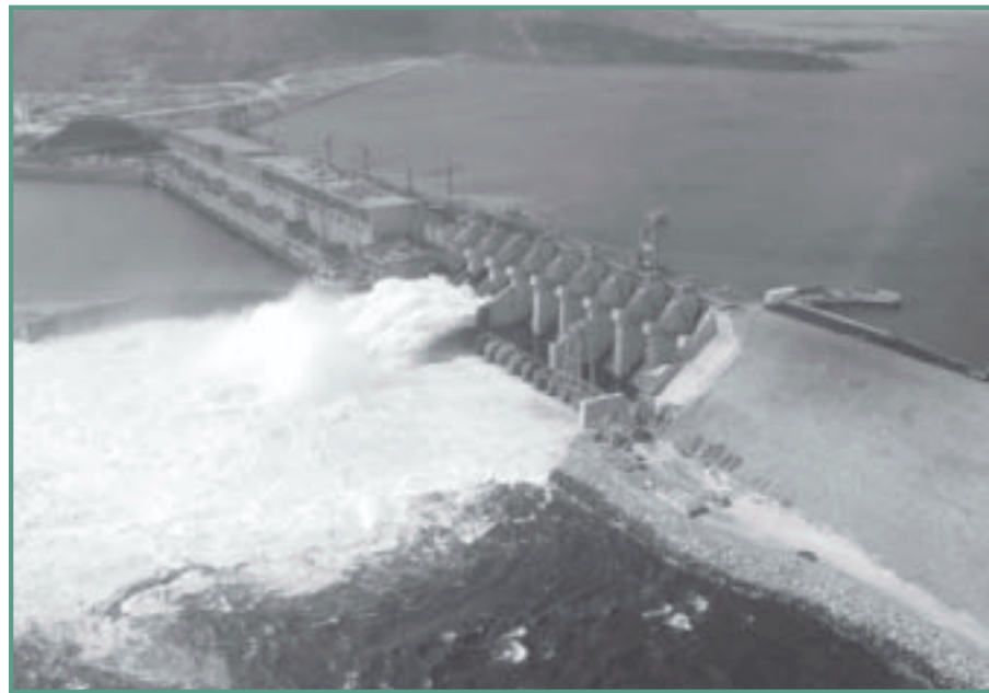
VENEZUELA • La centrale hydroélectrique de Caruachi, de 2 160 MW, a permis de satisfaire la demande croissante d'électricité en exploitant les ressources hydriques du Caroní (photo publiée avec l'aimable autorisation de CVG-EDELCA).
