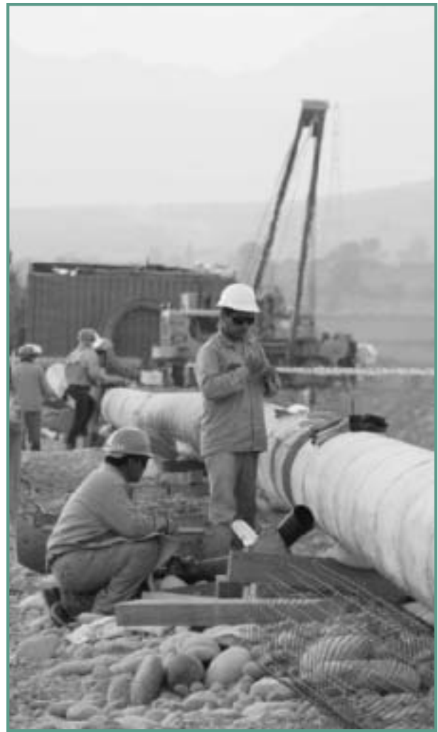
PÉROU • Le réseau de distribution du gisement de gaz naturel de Camisea fournit des ressources énergétiques essentielles à la région de Lima et de Callao.
