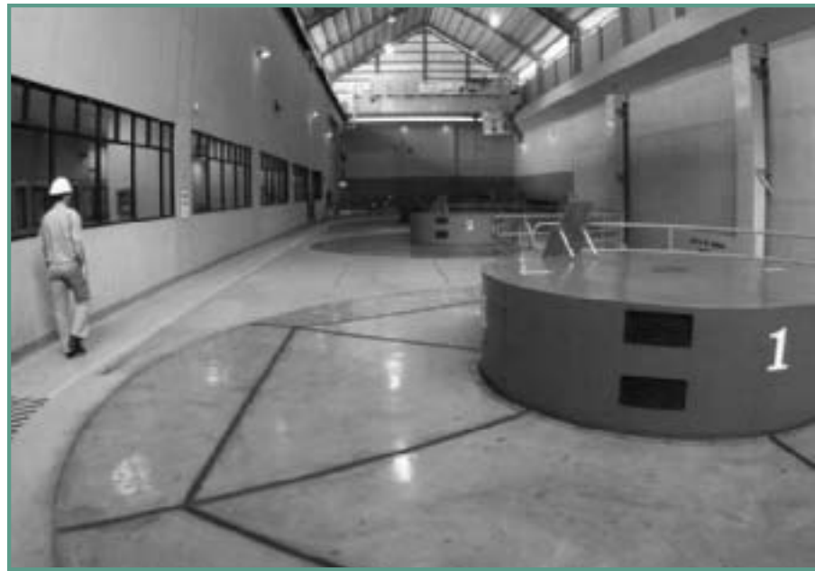
COSTA RICA • La centrale hydroélectrique d'Angostura a été construite au cours de la phase III du Programme de développement d'énergie électrique, en vue d'augmenter la couverture, d'assurer un service de qualité et de conserver l'énergie.
