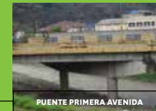
PUENTE PRIMERA AVENIDA
