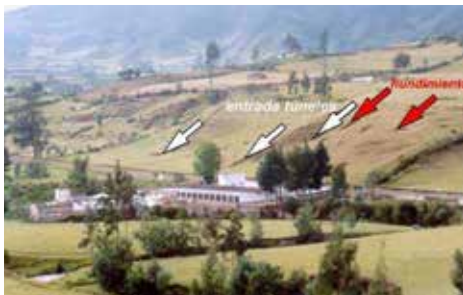
Ilustración 52. Tipología de túneles
