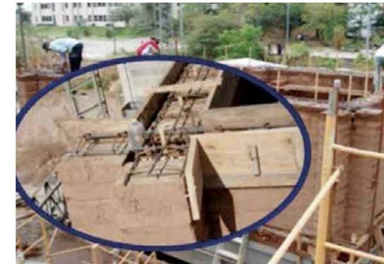
Figura 40. Ejemplo de construcción de vivienda usando el material de adobe reforzado.
